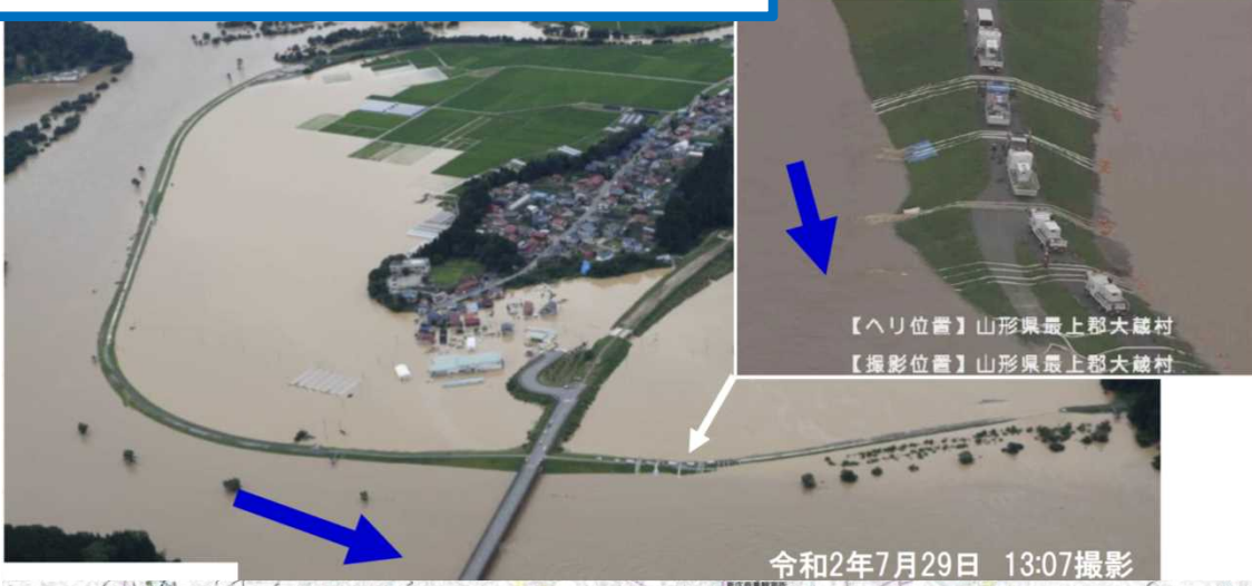
大蔵村白須賀 排水ポンプ車排水状況
