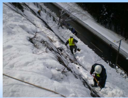
雪崩を防ぐために法面に登って人力で雪を落とします
