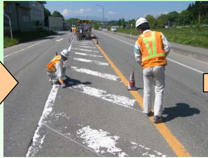
作図し塗布箇所を確定します
