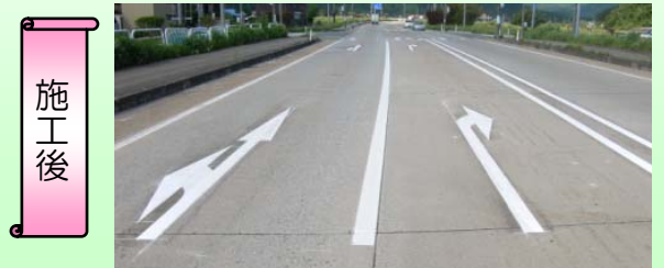
反射材としてガラスビーズを同時に散布します
