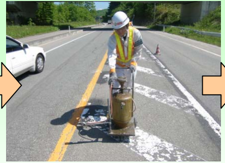
プライマーを塗布し接着力を向上させます
