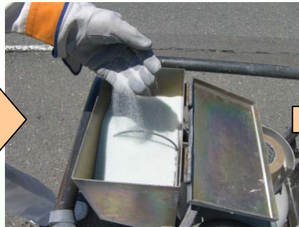
反射材としてガラスビーズを同時に散布します
