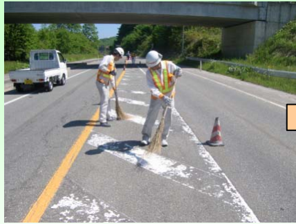
まず塗布箇所の清掃をします
