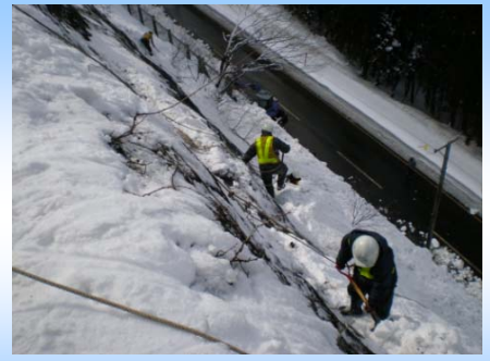
雪崩を防ぐために法面に登って人力で雪を落とします
