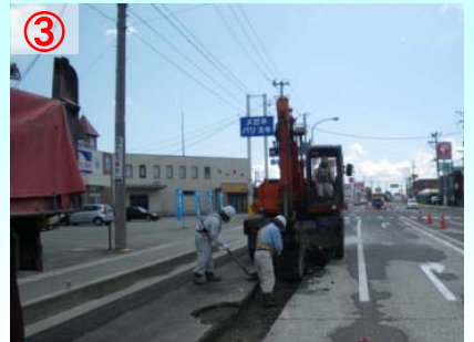
③ 深い所まで亀裂が入っている箇所は下の層から舗装し直します
