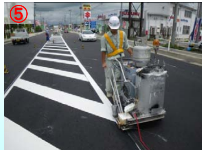
⑤ 新しいアスファルト層の上に区画線を引き直します
