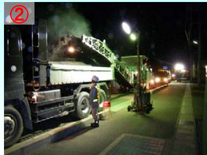
② 切削機械で傷んだ路面のアスファルト層を削り取ります
