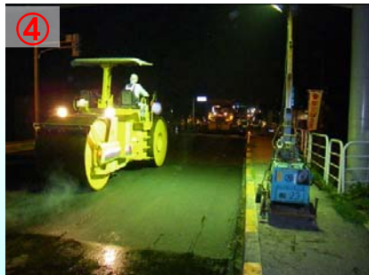
④ 新しいアスファルト合材を敷き詰め、ローラー車で締め固めます
