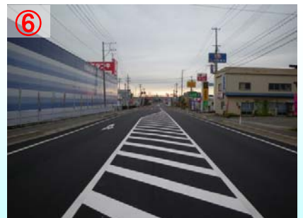
⑥ 補修後 走行が快適になるほか、周辺への騒音・振動も減少します
