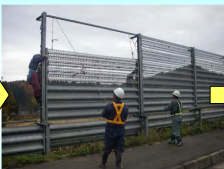
パネルを吊り上げます
