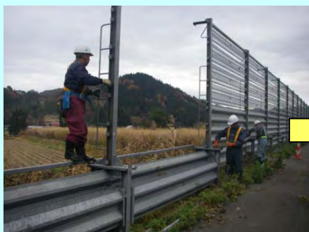
まず支柱を立ち上げます
