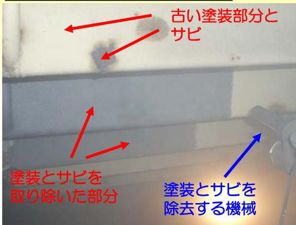
歩行スペースと板をへだてた作業スペースでは、特殊な機械を使って古い塗装とサビを取り除き、その後新しく塗り直します。
