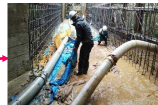
足場や型枠があるため、すべて人力による清掃を行いました。
