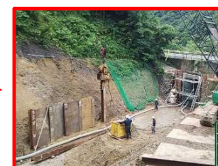
土留工を追加して施工
