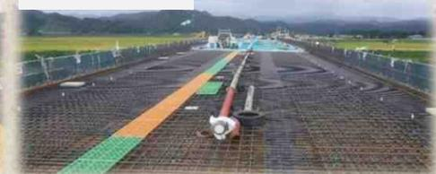
見学時は床版鉄筋組立まで完了していました。現在はコンクリート打設まで完了しています。
