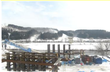
H26年1月：積雪の中、施工を開始しました。
