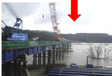
H26年3月：大型クレーンを使って、川の中に仮栈橋を伸ばしていきました。
