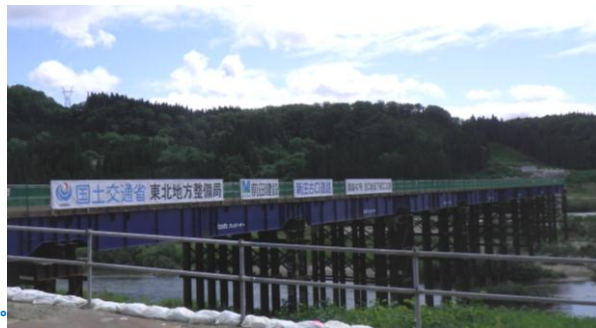
現在：仮栈橋(通路栈橋)完成
