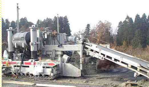
連続鉄筋にコンクリートを流し込んでいる様子
