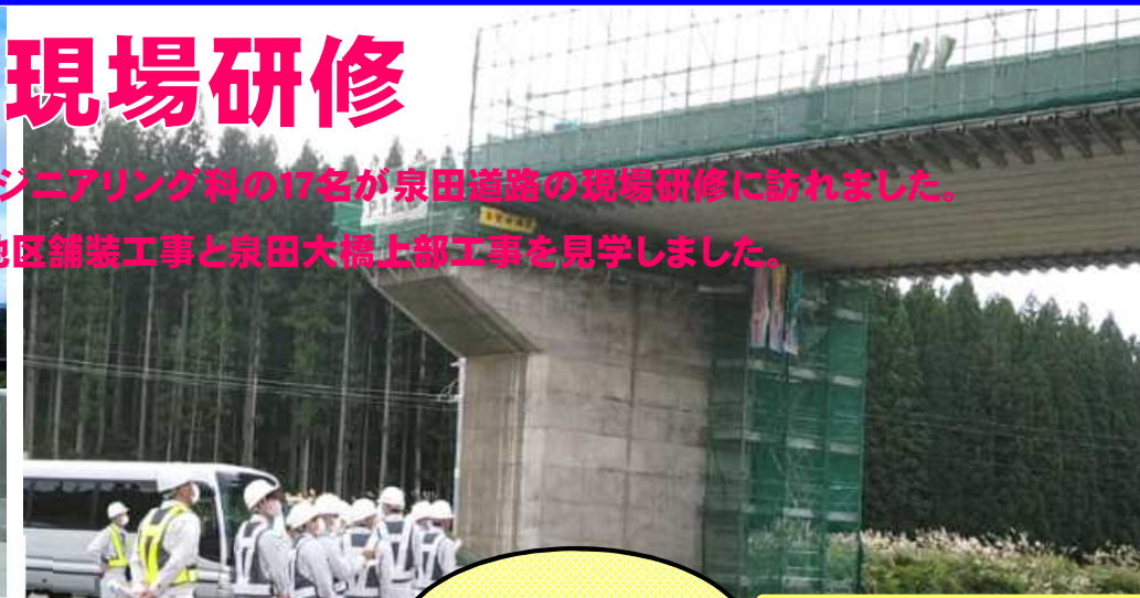
泉田大橋上部工事
