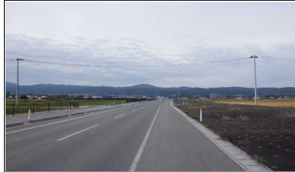
県道 山形山辺線BP 付近
