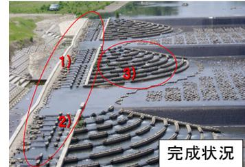
1) 粗石付き斜路 2) 切欠付階段式 3) 扇形階段式
