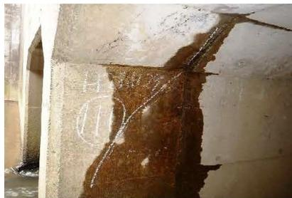
樋管・樋門の漏水状況
