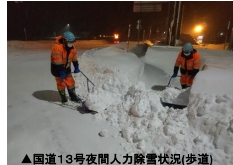
▲国道13号夜間人力除雪状況(歩道)
