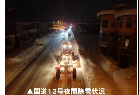
▲国道13号夜間除雪状況
