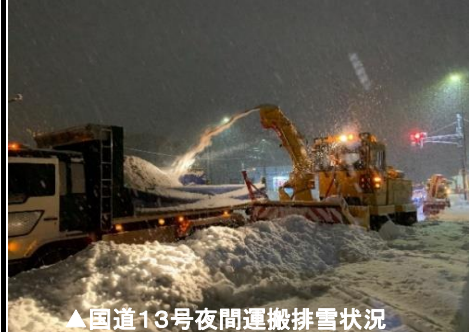
▲国道13号夜間運搬排雪状況
