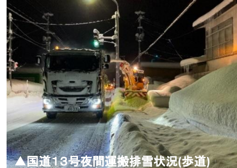
▲国道13号夜間運搬排雪状況(歩道)
