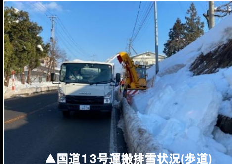
▲国道13号運搬排雪状況(歩道)
