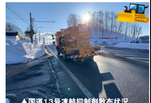
▲国道13号凍結抑制剤散布状況
