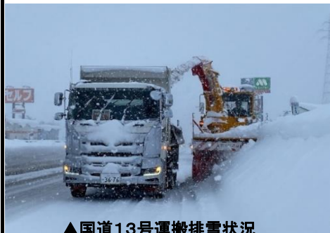
▲国道13号運搬排雪状況
