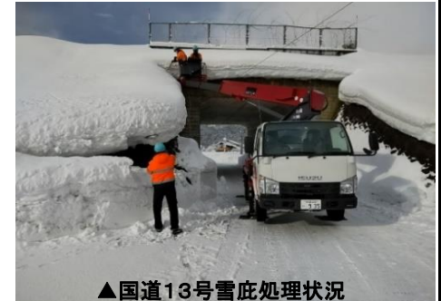
▲国道13号雪底処理状況
