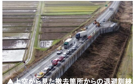
▲上空から見た撤去箇所からの退避訓練
