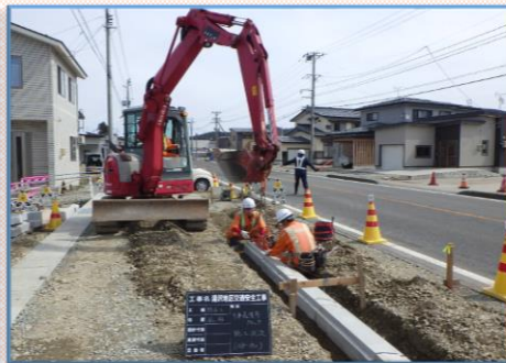
縁石設置状況
