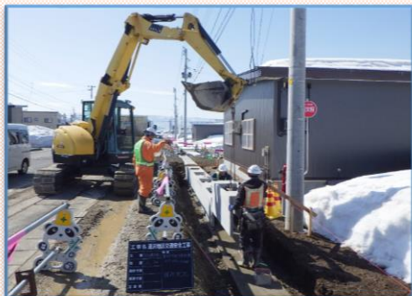
側溝設置状況
