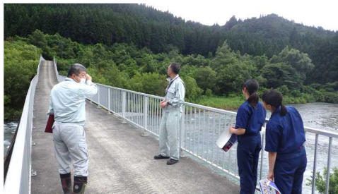
生保内川大暗渠砂防堰堤
