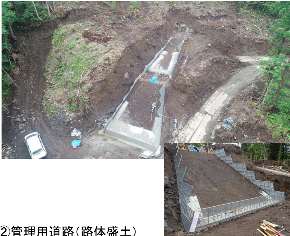
①水沢第2堰堤工事(コンクリート打設)
