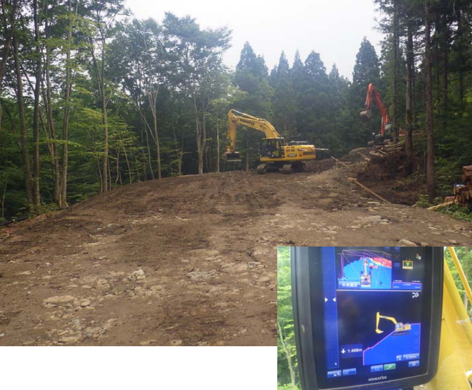
②管理用道路(路体盛土)
