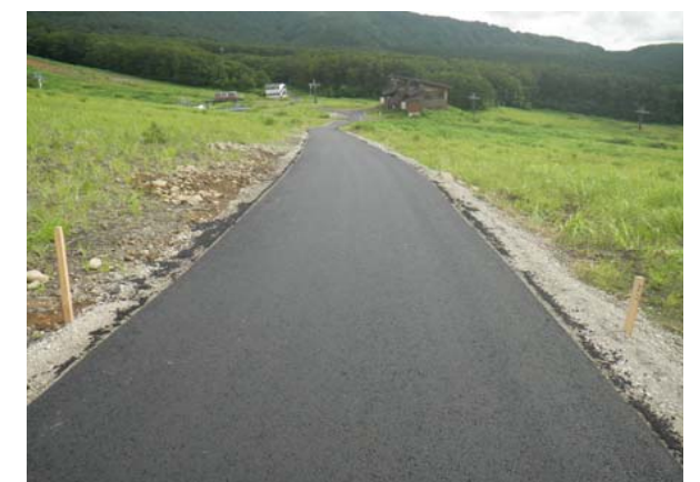
・道路補修工事(スキー場内)
