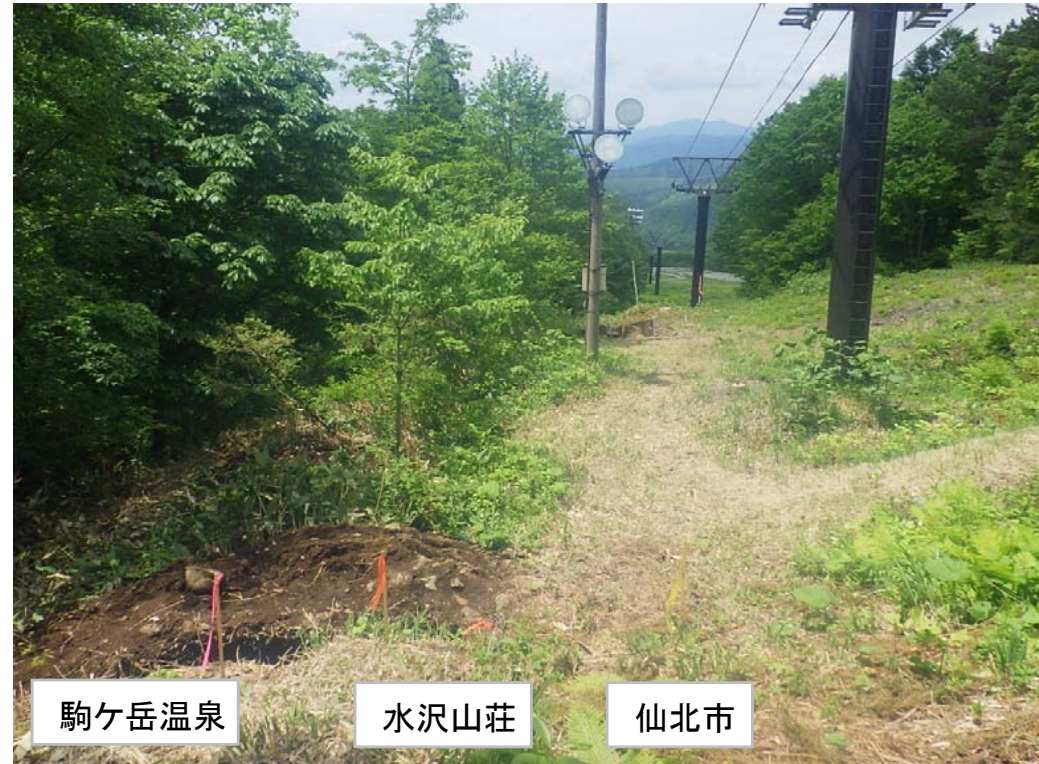
③温泉管切替工事(埋設位置調査)
