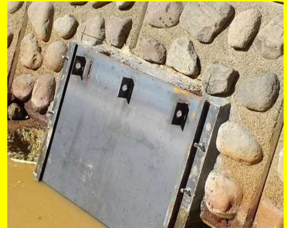
景観に配慮した残存型枠のため凸凹があって鉄板がうまくはまるか心配でした
