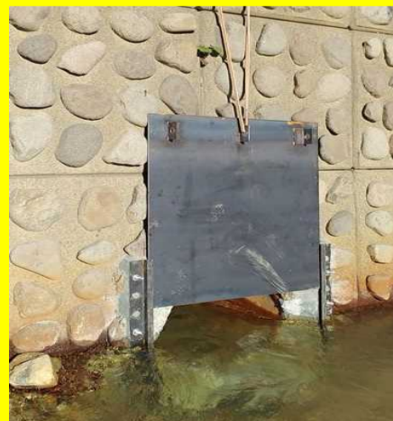
景観に配慮した残存型枠のため凸凹があって鉄板がうまくはまるか心配でした
