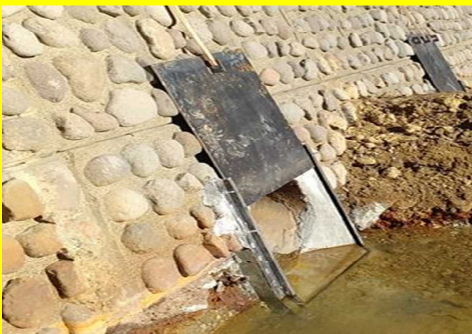
景観に配慮した残存型枠のため凸凹があって鉄板がうまくはまるか心配でした
