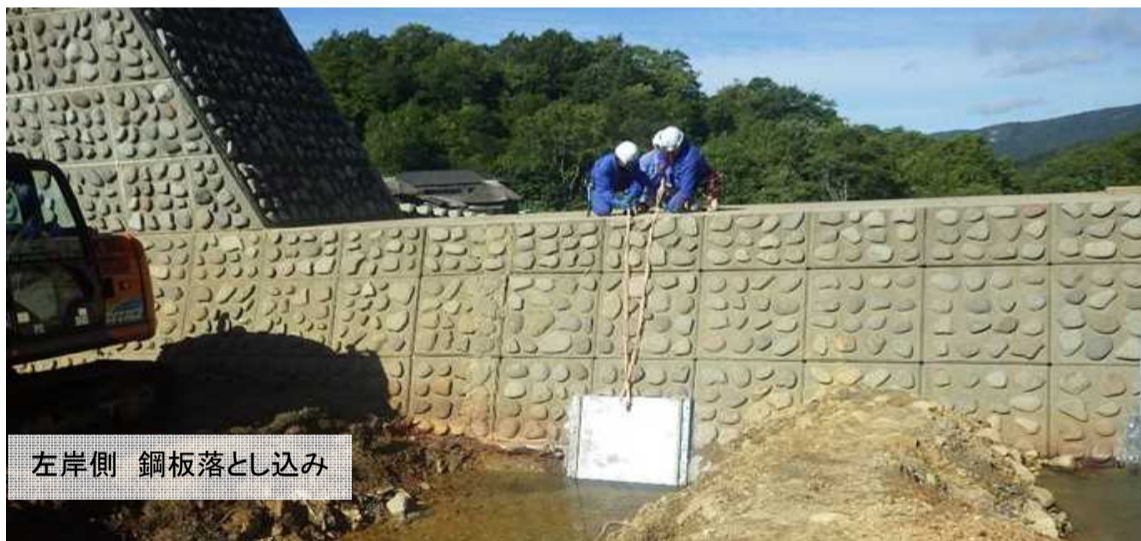
鋼板セット確認調整
