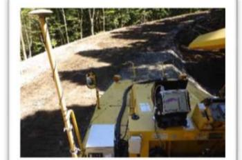
※管理用道路の施工においてはICT (GPSを利用してコンピューターで機械を制御) を活用しています
