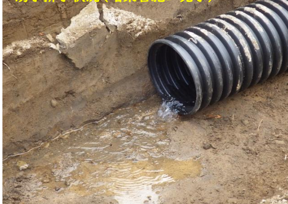
応急処理完了(湧水処理・土留工)
