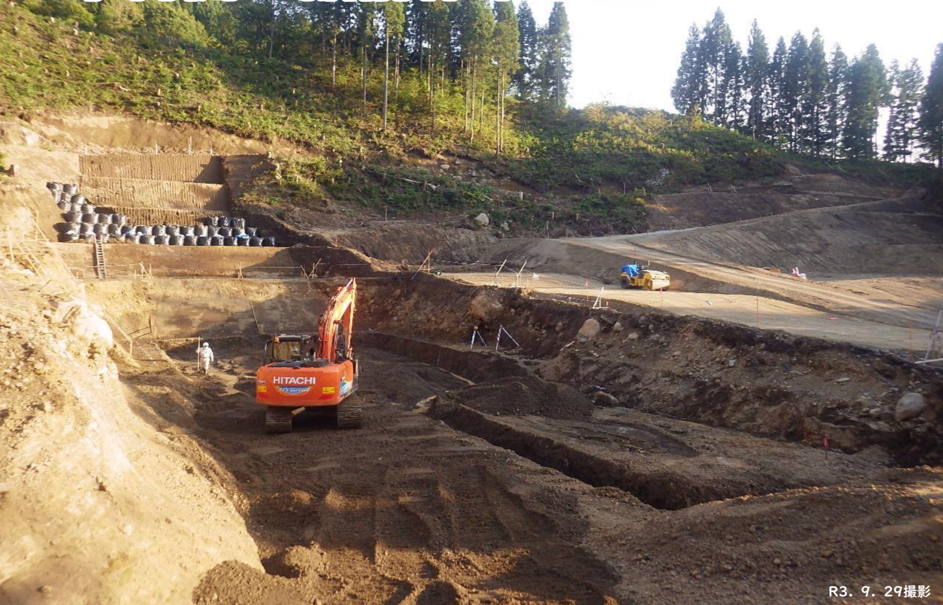
湧水処理(暗渠管施工状況)
