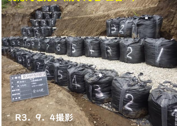
応急処理完了(湧水処理・土留工)
