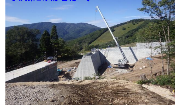
水沢第2砂防堰堤工事
