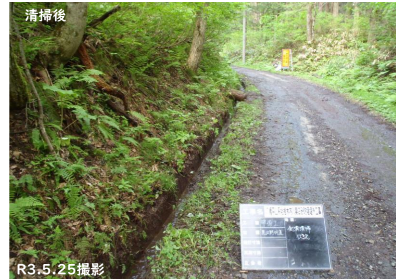
● 林道の側溝に土が溜まり、側溝の機能をはたしていなかったため、側溝清掃作業を行いました。清掃後は順調に排水が流れています。
