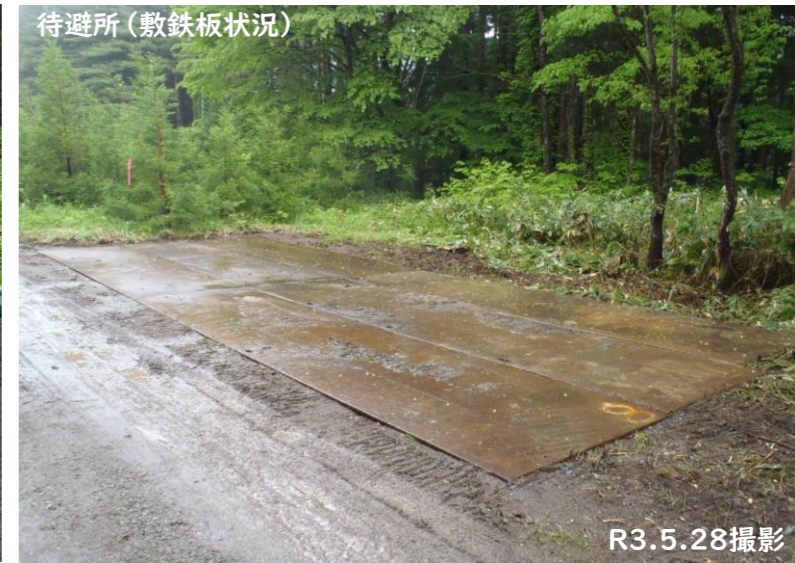
● 市道及び林道の道路幅が狭く、車両の交差ができないため待避所の設置を行いました。個人所有箇所や埋設管がある箇所には鉄板にて待避所を設置しております。
