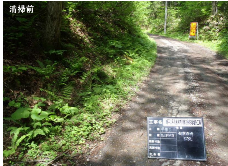
● 林道の側溝に土が溜まり、側溝の機能をはたしていなかったため、側溝清掃作業を行いました。清掃後は順調に排水が流れています。
