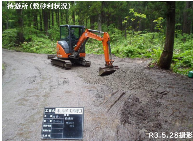
● 市道及び林道の道路幅が狭く、車両の交差ができないため待避所の設置を行いました。個人所有箇所や埋設管がある箇所には鉄板にて待避所を設置しております。
