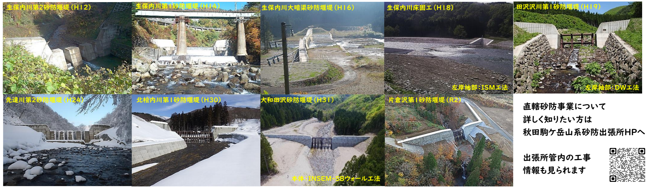
● 当社は直轄砂防堰堤の施工を平成12年完成の生保内川第2砂防堰堤から現在まで9基の砂防堰堤の新設及び改築工事を行ってきました。
