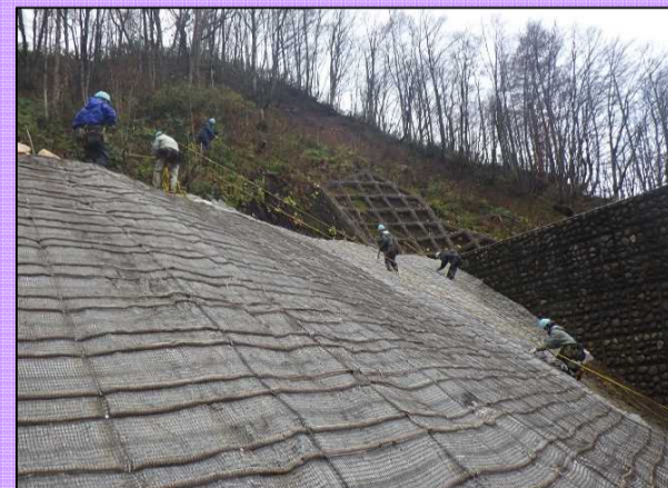
法面保護のため周辺からの飛来種子により緑化させるためのマットを張りました。
