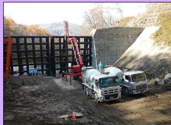
最終コンクリートの打設状況です。
