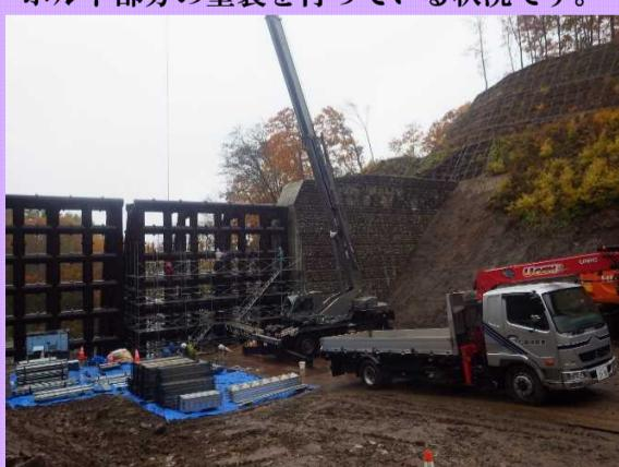
鋼製堰堤の組立てが終わり足場を解体している状況です。
