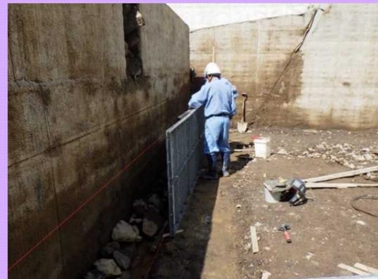
軽量の金属製の型枠を使用して型枠を組みました。
