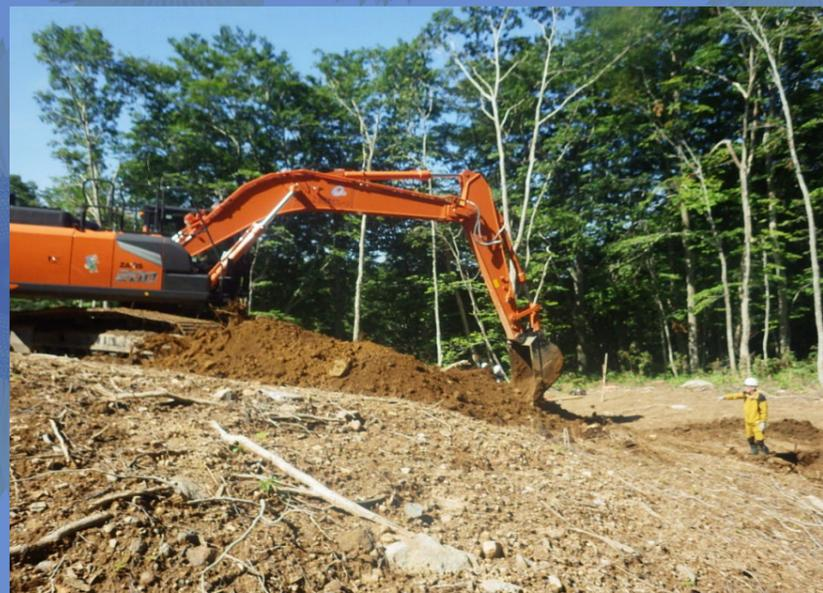
大型のバックホウで伐採した木を運び出すための道を作っています。伐採した木は現場で規定の長さに切断して仮置き場に運搬し、枝葉は産廃として処分します。
