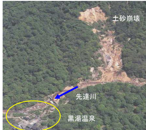
■平成9年5月発生 せんだつがわ 先達川上流崩壊地
