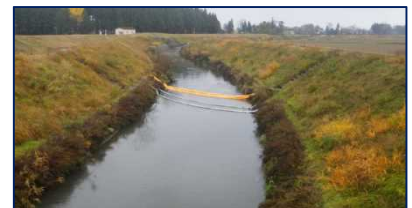
油が流出した付近の オイルフェンス設置写真
