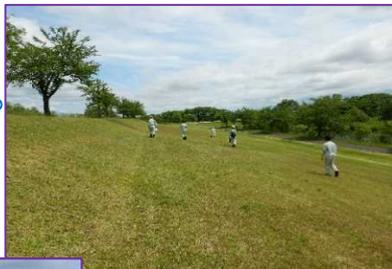
堤防にはイタドリという植物がいたるところで群生しています。繁殖力があり葉も大きく根茎が地中に深く根付き堤防の空洞化、弱体化に影響することも懸念されています。このイタドリを駆除するために、薬剤注入などを行い生育の抑制に努めています。
