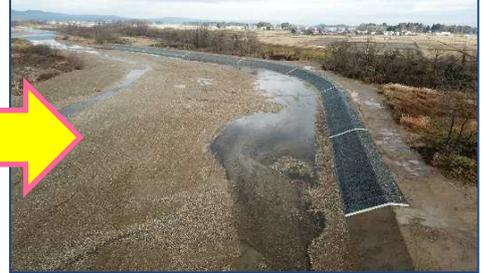
今年度行われた災害復旧工事は、大森地区・睦合地区ともに令和元年10月13日の台風19号に伴う降雨による出水で被災した河岸の復旧を目的とした護岸工事です。護岸で保護しないと河岸がどんどん削られ、堤防まで危険な状態となるため、極めて重要な工事となっています。
