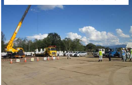
雄物川上流玉川四ツ屋地区護岸補修工事
