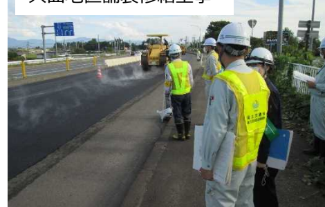
大曲地区舗装修繕工事
