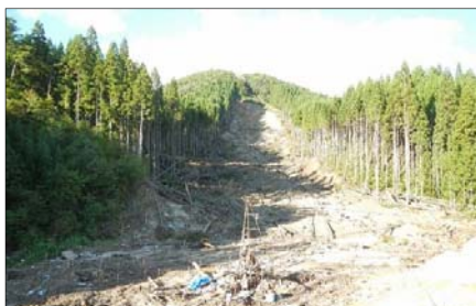
工事着手前(9月27日撮影)
