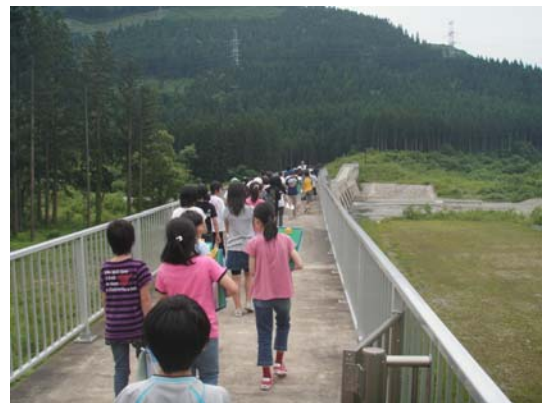
○生保内川遊砂地大暗渠堰堤天端
