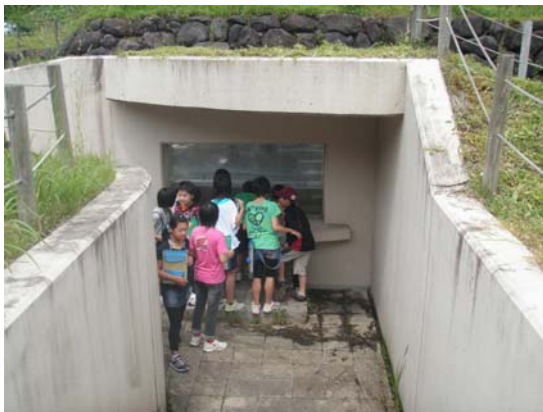
○小先達川第一砂防堰堤魚道観察
