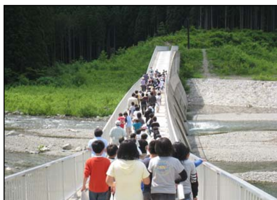
○生保内川 大暗渠を徒歩探検
