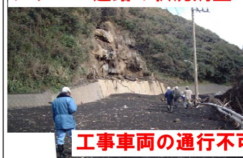
アクセス道路の状況調査
