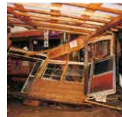
孫六温泉被害状況
