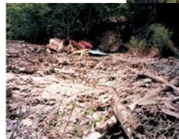
土石流に流された赤川温泉(平成9年5月11日)
