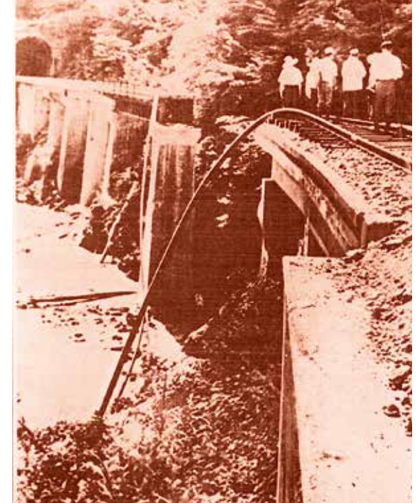
田沢湖線被害状況
