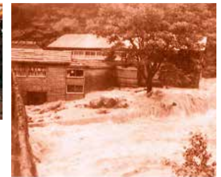
孫六温泉被害状況
