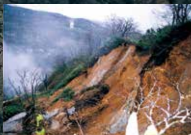
先達川上流土砂崩落状況(平成9年)
