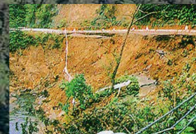
台風による被害状況/西山・生保内線(平成3年)
