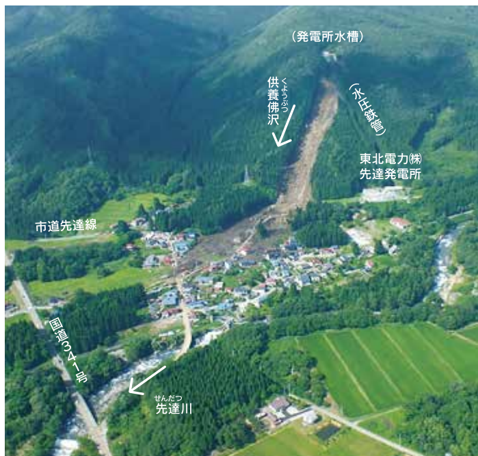
土砂崩落状況(平成25年8月12日撮影)
