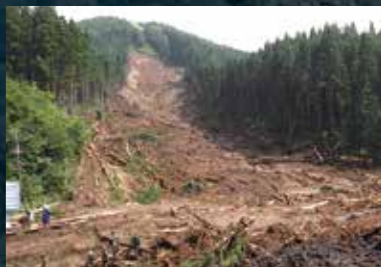
供養佛地区土砂崩落(平成25年)
