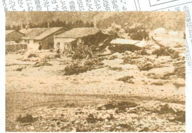
土砂に埋没した向生保内地区の民家
