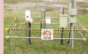
被災箇所近傍の一時避難場所に 臨時雨量計を設置
