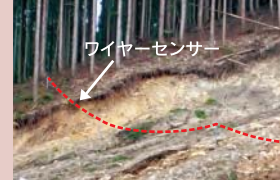
崩壊地中腹にワイヤーセンサーを設置
