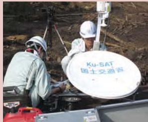
TEC-FORCEによるKu-SAT設置作業
