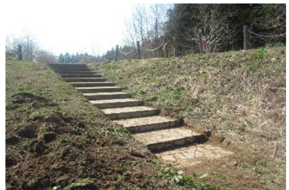
○土砂を撤去しました
