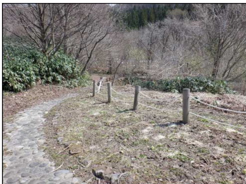
●木杭の一部劣化
