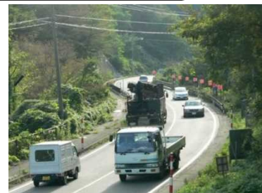
▲国道7号の線形不良箇所
