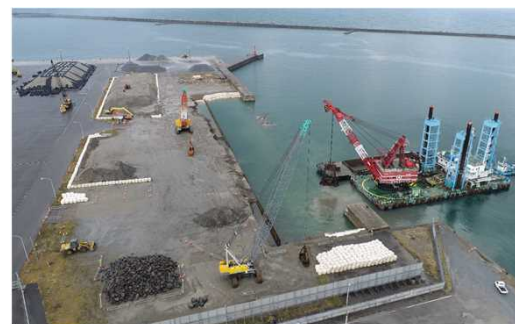
▲岸壁の整備状況
