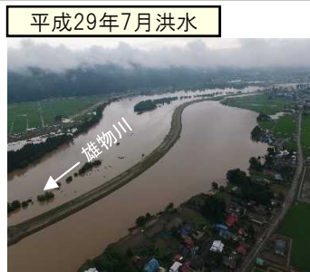
[雄物川本川の浸水状況]
