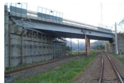
▲白沢跨線橋全景
