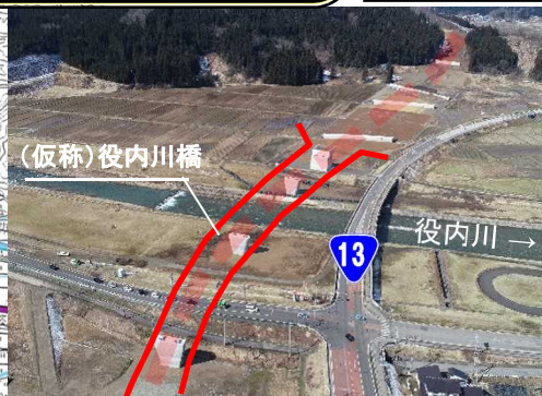
▲令和2年3月の工事進捗状況
