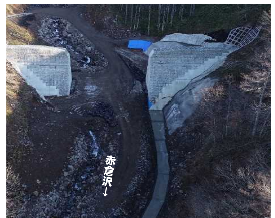
施工状況(R1)
