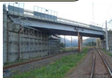
▲白沢跨線橋全景
