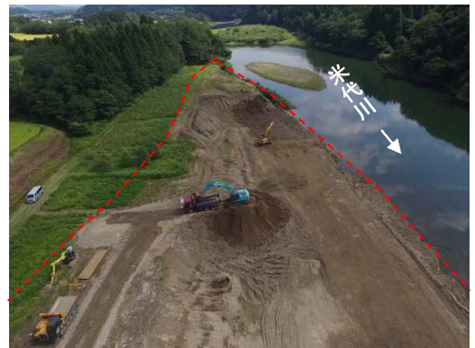
河道掘削施工状況(R元年9月末時点)
