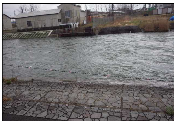
▲注意喚起のトラロープにつけたピンクテープが劣化していました。 (秋田市:三角沼)
