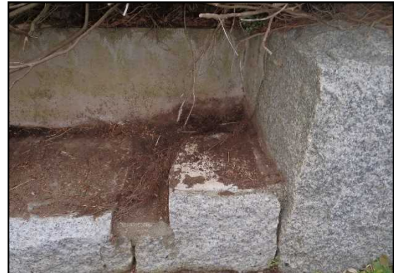
▲腐食した木材、釘を撤去しました。
