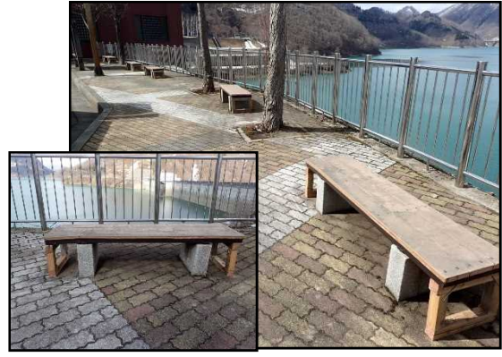
▲サポート柱をベンチ下に設置し、応急措置をしました。 (速やかに補修・交換を実施します。)
