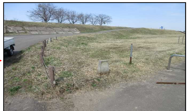
▲支柱を撤去しました。
