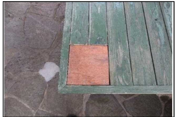
▲破損箇所を切り取り、板材で補修しました。
