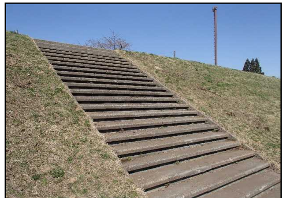
▲土砂を撤去しました。
