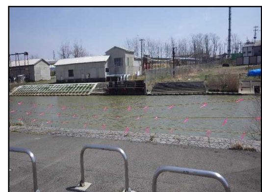
▲トラロープを張り直し、ピンクテープを交換しました。
