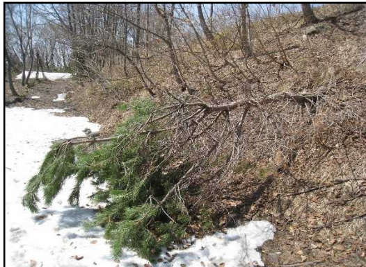
▲倒木がありました。 (仙北市:小先達川第一砂防堰堤(サポーカーチャーパーク))
