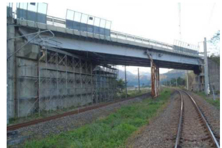
▲白沢跨線橋全景
