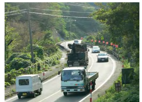
▲国道7号の線形不良箇所
