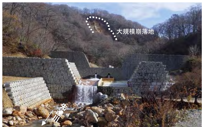
施工状況(H30)
