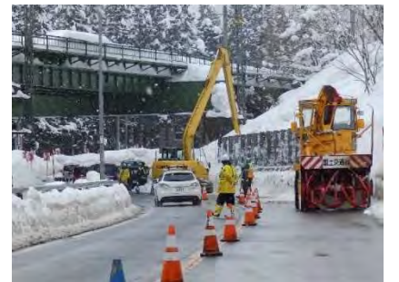
▲雪崩予防作業による片側交通規制
