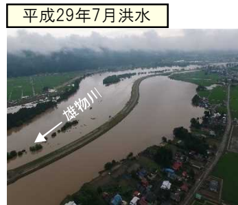
[雄物川本川の浸水状況]
