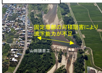
山田頭首工の現状
