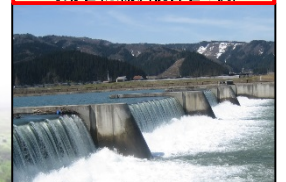
可動堰(※濁沢統合堰の例)
