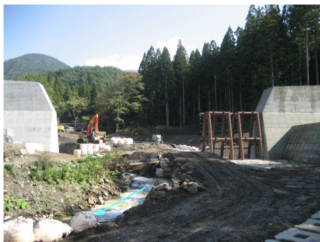
平成28年度施工状況
