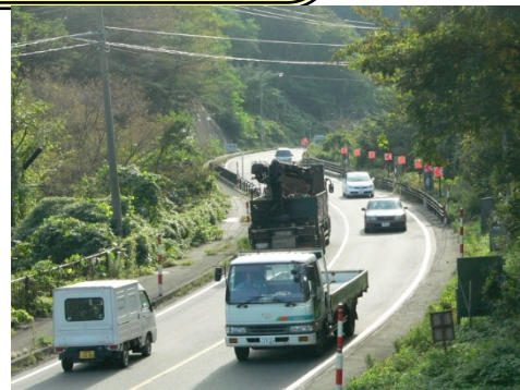
▲小繫地区の線形不良箇所
