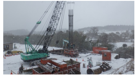
▲橋梁下部工(場所打ち杭)施工状況
