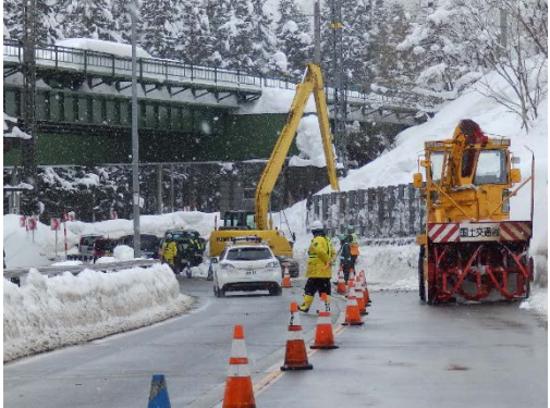
片側交互通行規制を伴う雪崩・落雪予防作業
