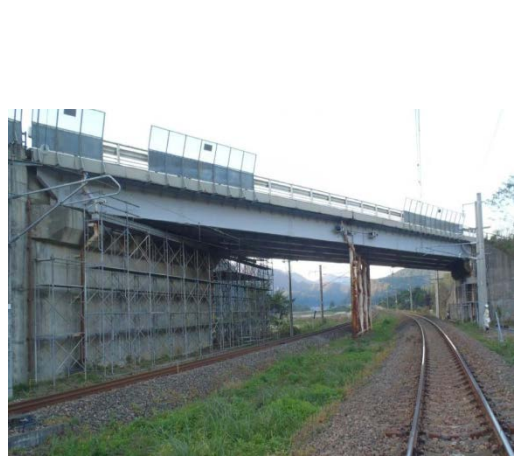
▲白沢跨線橋全景
