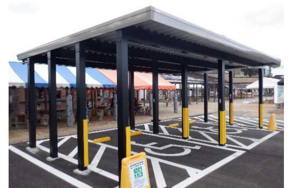
カーポート設置(障がい者スペース)
