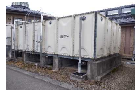
貯水槽の設置
