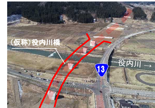
▲令和2年3月の工事進捗状況
