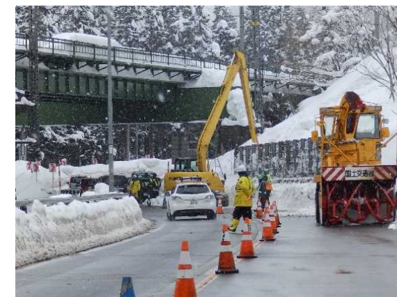
▲雪崩・落雪予防作業の状況
