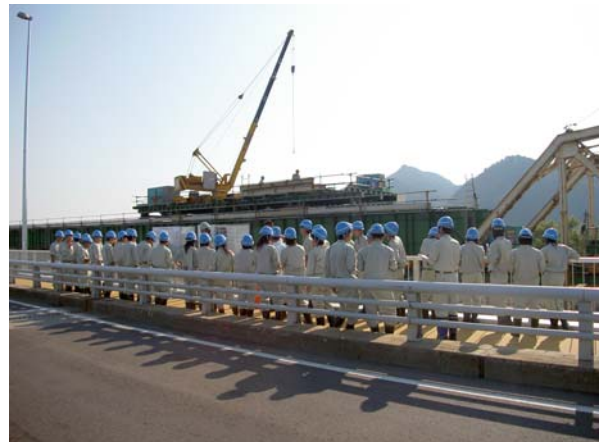
☆ 旧玉川橋解体・撤去工事を見学 ☆
